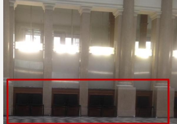
Luft einbringung Kassenhalle
