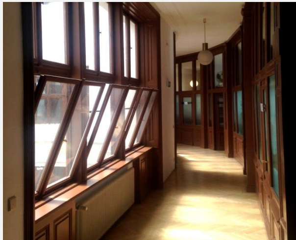
Kipfenster zw Luftraum und Büros
