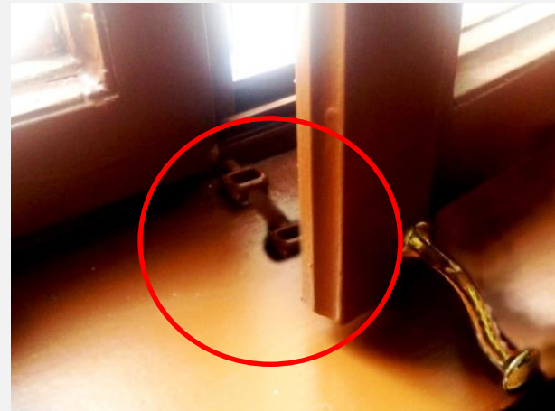
Doppelter Beschlag für Hinterlüftung
