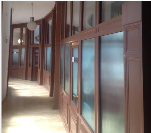
Bürotüren offenhalten für Nachtlüftung
