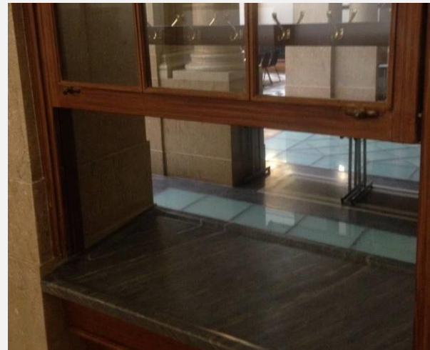
Schiebefenster zw Luftraum und Büros
